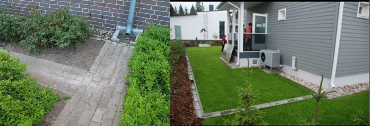
Kuva 13. Esimerkki kattovesien johtamisesta. Esimerkissä hulevedet johdetaan syksytorvista betonista kourua myöden viherkaistaleelle, joka sijaitsee riittävän etäällä rakennuksesta. Vasen kuva on Hannoverista ja oikea kuva Tampereen Vuoreksesta. 8
