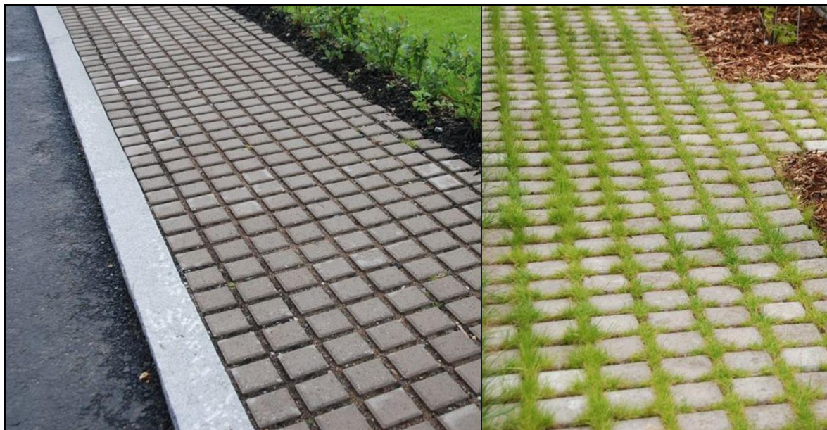
Kuva 10. Esimerkkejä lämpäisevien päällysteiden käytöstä. 8
