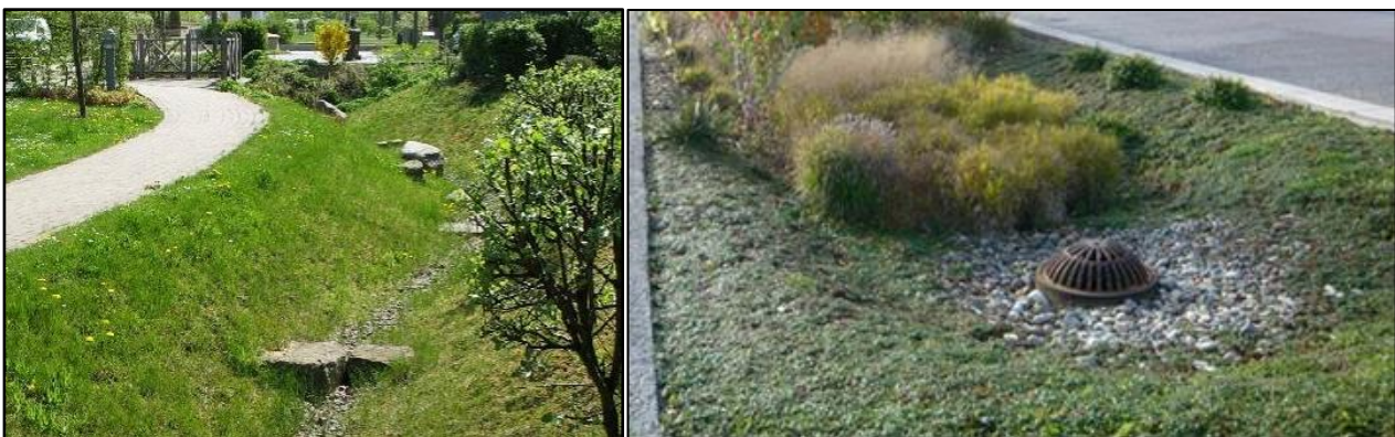
Kuva 14. Vasen kuva: Esimerkki hulevesien pintajohtamista kadun reunaosassa, johon on istutettu kasvillisuutta ja rakennettu pohjapatoja. 8 Oikea kuva: Esimerkki katualueen viherpainanteesta, jossa on ylivuotojärjestelmä hulevesiviemäriverkkoon (Seattle, USA). 8
